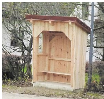
Die Einwohner von Reichertsmühle haben in Eigeninitiative ein neues Buswartehäuschen errichtet. Bild: hfz
